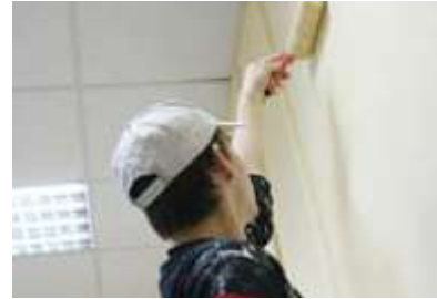
Monter zabudowy i robót wykończeniowych w budownictwie
