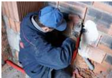
Monter sieci, instalacji i urządzeń sanitarnych
