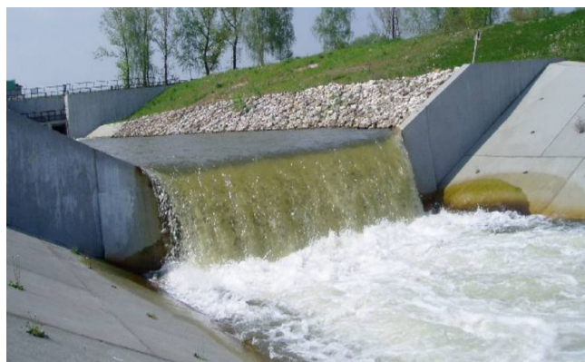
Fot. 6: Napelnianie zbiornika – przepustu pod drogą z kanałem wlotowym (Źródło: Rekultywacja i zagospodarowanie terenów pogórnich siarki w rejonie Tarnobrzega, Ochrona środowiska jako warunek rozwoju rejonu tarnobrzckiego, Kirejczyk J., Burchard T., Pantula Z., Przedsiębiorstwo Usługowo-Produkcyjne SIGMA BP Sp. z o.o., Tarnobrzeg, 2009 r)
