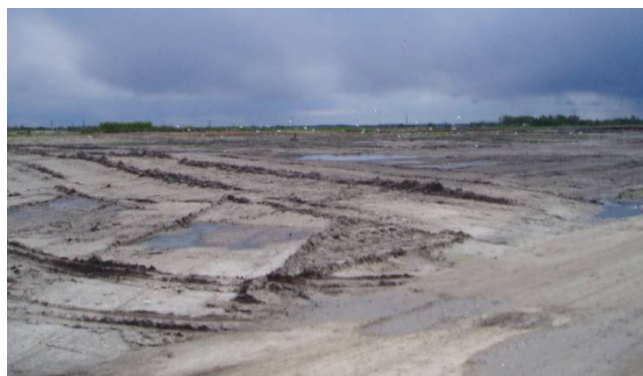
Fot.9: Układanie warstwy wapna w celu blokady zanieczyszczeń (Źródło: Rekultywacji i zagospodarowanie terenów pogórnich siarki w rejonie Tarnobrzega, Ochrona środowiska jako warunek rozwoju rejonu tarnobrzęskiego, Kirejczyk J., Burchard T., Pantula Z., Przedsiębiorstwo Usługowo-Produkcyjne SIGMA BP Sp. z o.o., Tarnobrzeg, 2009 r).
